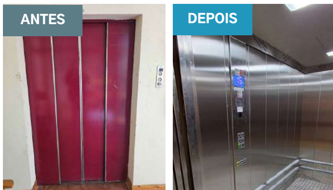
CAS OEIRAS - UF2/SAMED Substituição de monta-cargas, UF2/SAMED
